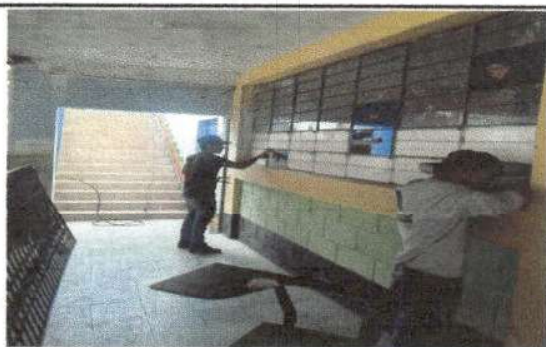
Foto 5: Colocación de balcones en el segundo nivel del módulo 1
