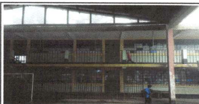
Foto 6: Vista general de los remozamientos, puertas, balcones y barandas.
