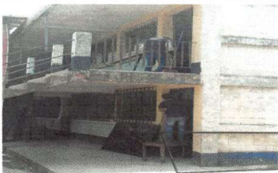
Foto1: Colocación de las puertas metálicas del módulo 2
