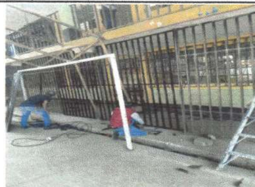
Foto 4: Barandal de la cancha ya colocado.
