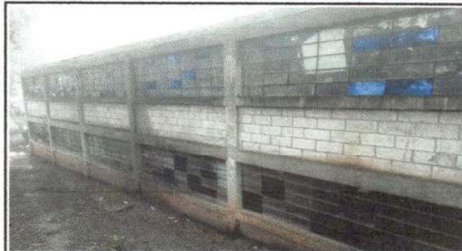
Foto 2: Los vidrios ya colocados en el lado de atrás de la escuela del módulo 1
