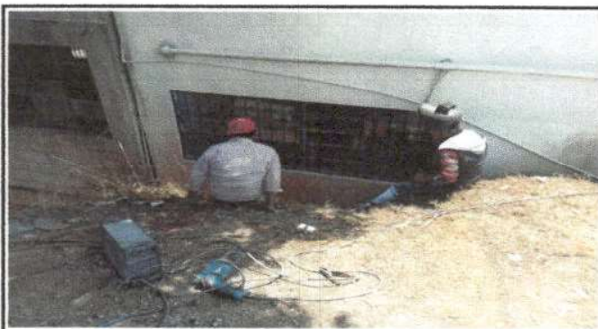
Foto 3: Colocación de vidrios y balcón a la dirección de la escuela
